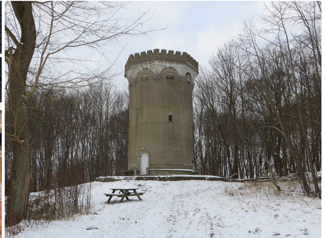
Vandtårnet, hvor vi skal have nyt unikt design i miniformat med klatrevæg og faldunderlag.
