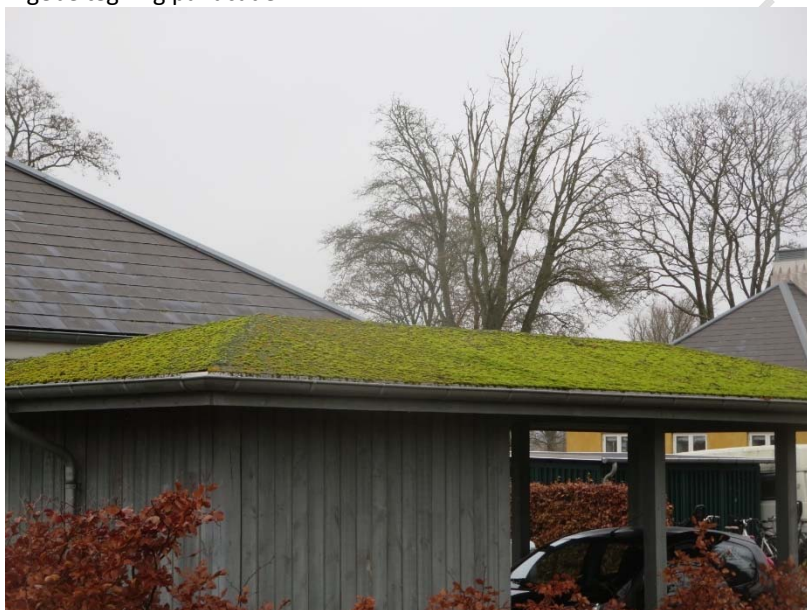
Mos og algelægning på tagbeklædning carportsbygning.
