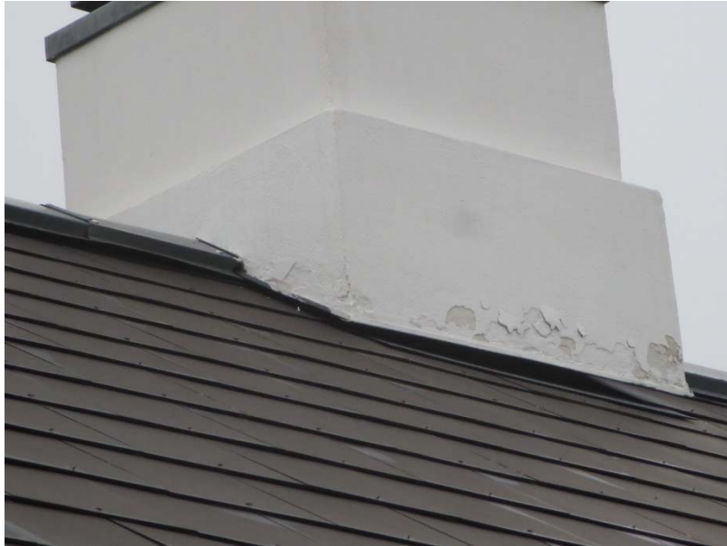
Afskalning af maling og puds ved ventilationsskorsten.
