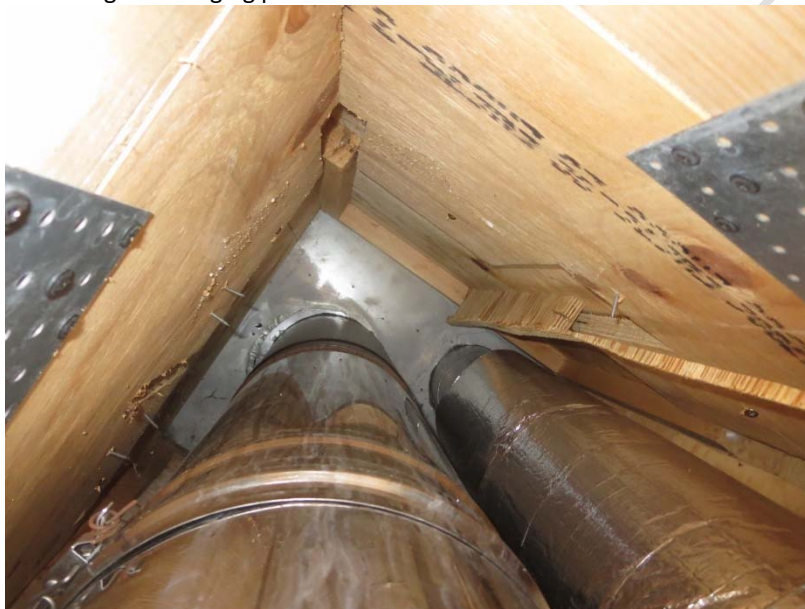
Ventilationsskorsten set indefra, udført som en trækasse.
