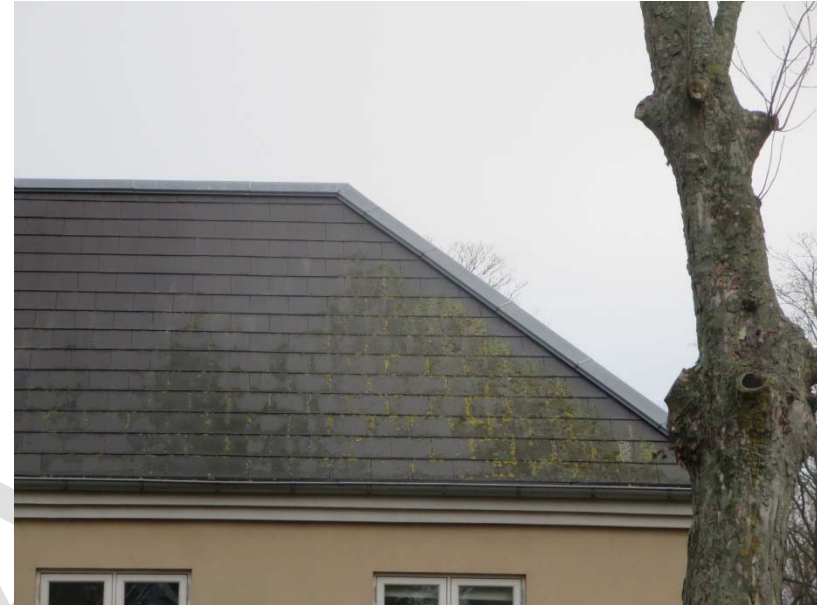
Mos og algebelægninger på tagbeklædning.
