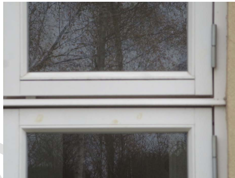
Gennemslag ved knaster på trævinduer.
